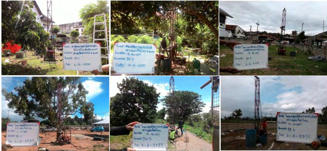
รูปที่ 3 ภาพถ่ายหลุมเจาะสำรวจเพิ่มเติมทั้ง 6 หลุม
