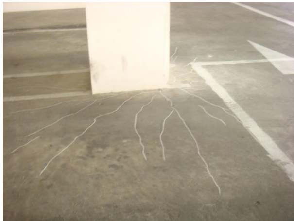
(ก) ด้านบนพื้นเนื่องจากกำลังต้านทาน โมเมนต์ลบและแรงเฉือนทะลุไม่เพียงพอ
