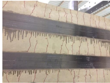
(ข) ความเสียหายบริเวณใต้ท้องพื้น
