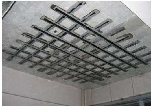
(ข) การเสริมกำลังด้วยแผ่นวัสดุคอมโพสิตผิวล่างเพื่อเสริมกำลังต้านทาน โมเมนต์ดัด
