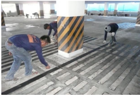
(ก) การเสริมกำลังด้วยแผ่นวัสดุคอมโพสิตที่ด้านบนเพื่อเสริมกำลังต้านทาน โมเมนต์ดัด
