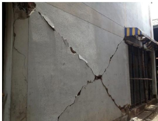
รูปที่ 1 ความเสียหายในผนังอิฐก่อและเสาจากเหตุการณ์แผ่นดินไหวขนาด 6.3 แมกนิจูด จังหวัดเชียงราย
