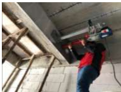
(a) การเจาะช่องเปิดในคานคอนกรีต
