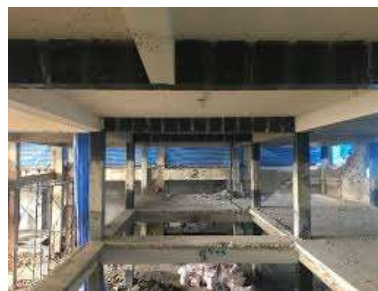
(b) การเสริมกำลังด้วย FRP กับองค์อาคารต่างๆ
