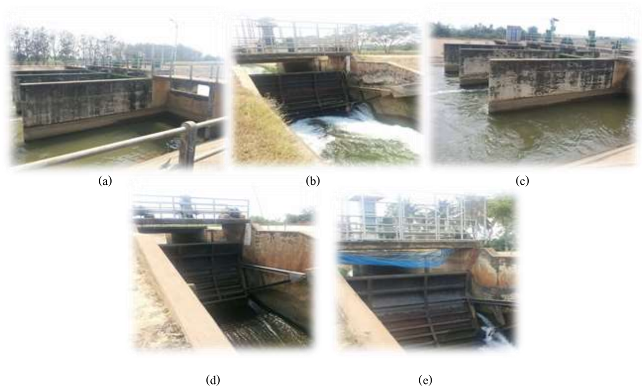
รูปที่ 2 อาคารชลประทานที่ทำการเจาะสำรวจดินและคอนกรีต
