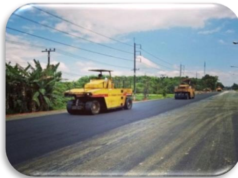
รูปที่ 4 การสร้างถนนแอสฟัลต์คอนกรีต
