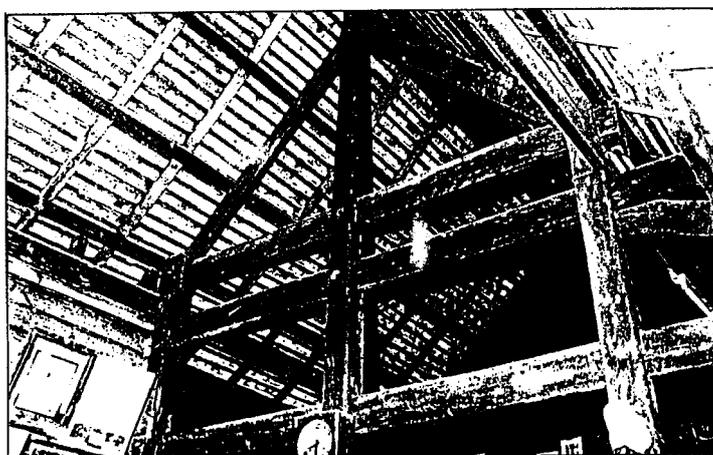
รูปที่ 13. โครงสร้างหลังคาเรือนไทยภาคใต้แบบดั้งเดิม
