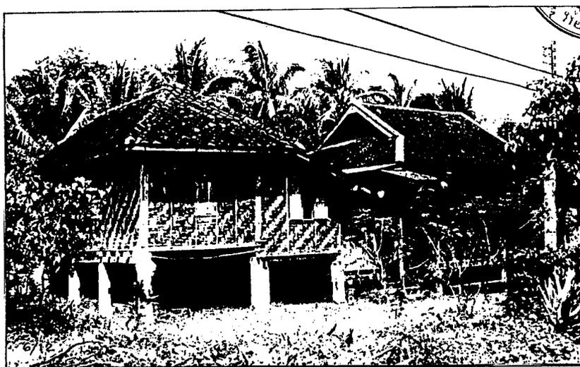
รูปที่ 10. เรือนเครื่องสับแบบยุคหลัง หลังคาบ้านหยาบมุงกระเบื้องว่าว และหลังคาบานอมุงกระเบื้องดินเผา
